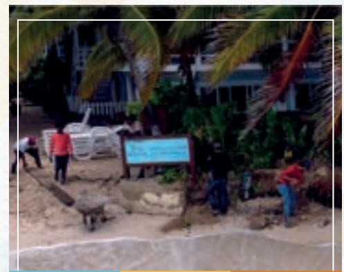
Foto: Trabajo de destrucción de muro que obstruía el acceso de pobladores a la Playa.
