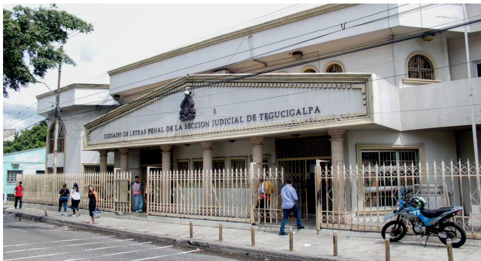
La oficina esta ubicada en el Barrio La Granja en las instalaciones del Juzgado de Letras Penal de Tegucigalpa
